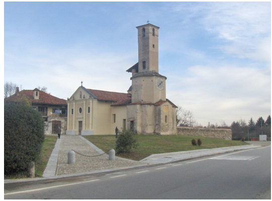
Il complesso del Battistero a lavori ultimati di riqualificazione dei percorsi esterni
