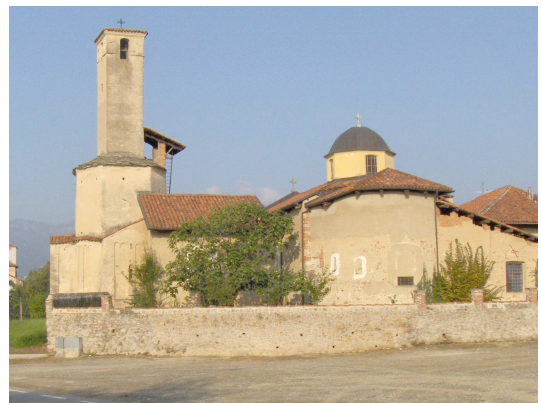
Il muro storico di cinta dopo i lavori di restauro
