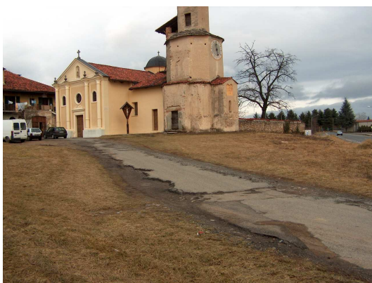
Il percorso esterno prima dei lavori
