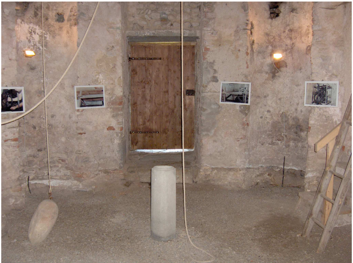
Pavimento interno e ingresso
